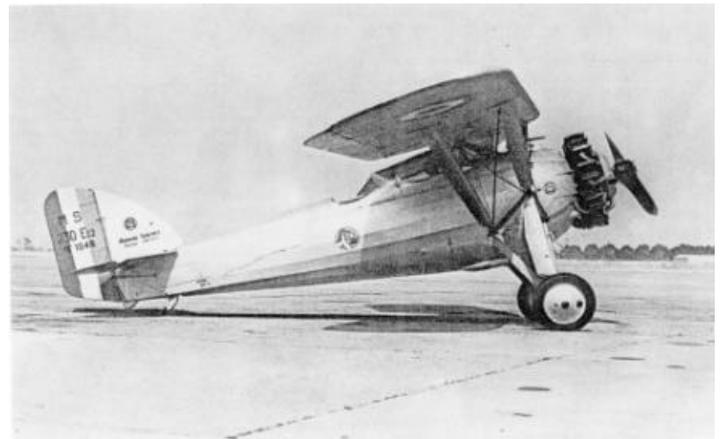
Le Morane-Saulnier MS-230, avion-école de l'Armée, une machine volante typique des années 1929-1930 à structure métallique entoilée, et homologuée dans la catégorie « avions de voltige ».
