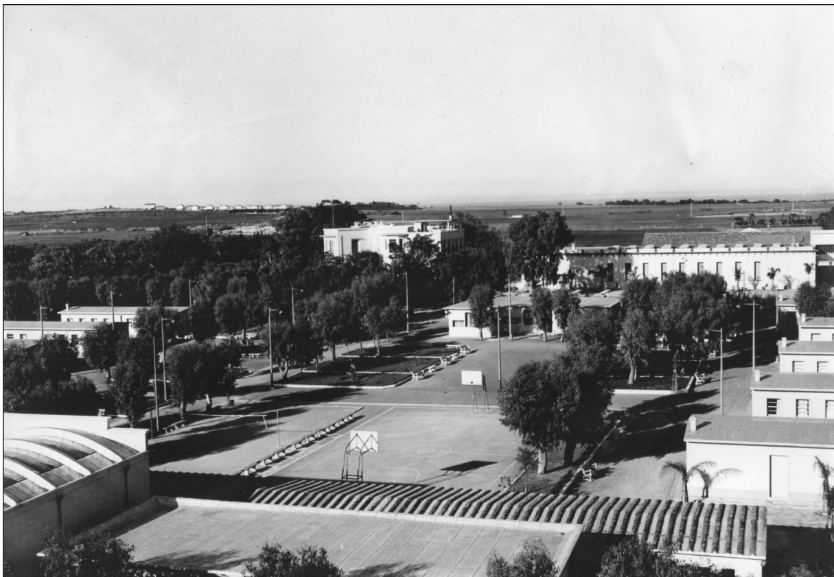
Photo prise du logement des enseignants - En arrière plan à gauche : bâtiment Administratif
