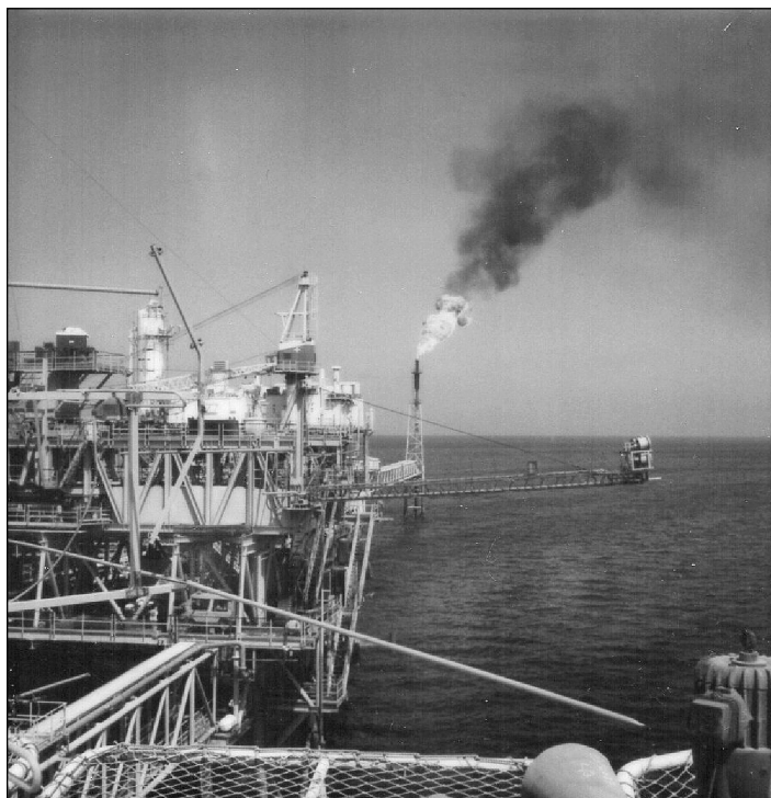
Plateforme off shore - gaz basse pression
