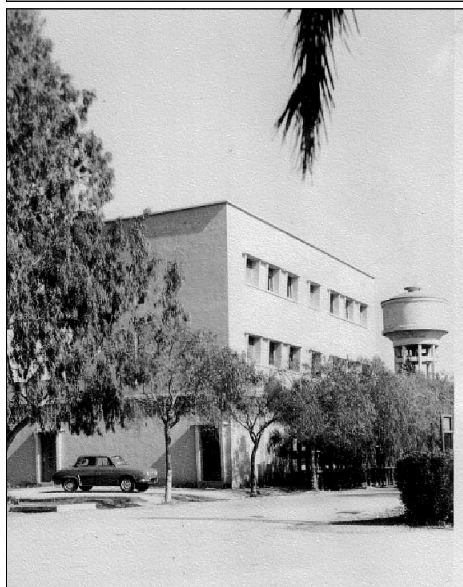
Logement du personnel
