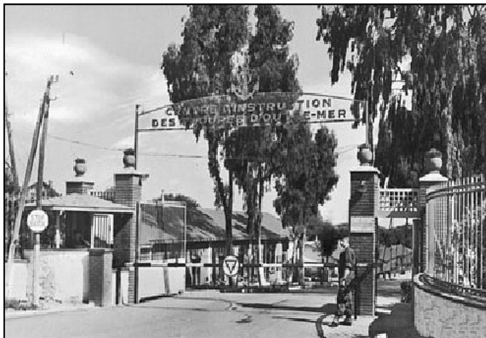
FORT-de L'EAU - Camp du Lido
