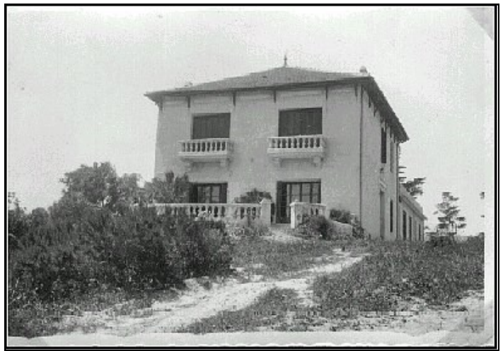
Bâtiment de la Direction
