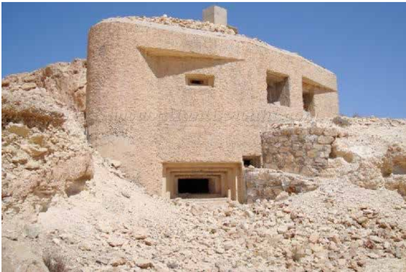
▼ Vestige d'un ouvrage de la ligne Mareth en Tunisie
