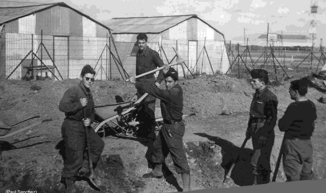
Le creusement de la piscine – Décembre 1960
