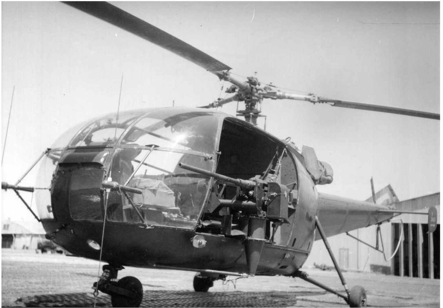
Alouette III n°02/BSI du GE-ALAT, le 23 août 1961 à Sétif, pour expérimentation du canon Mauser MG 151 de calibre 20 mm monté en sabord gauche (photo Bernard Chenel).
