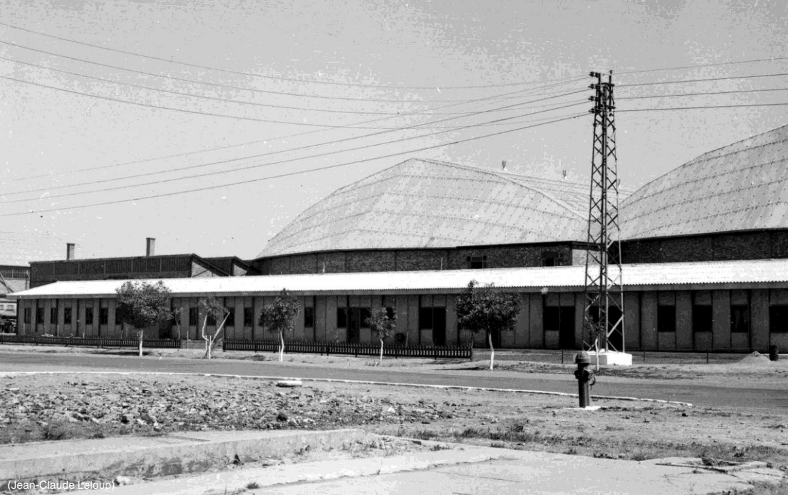
L'arrière des hangars Nord en 1957
