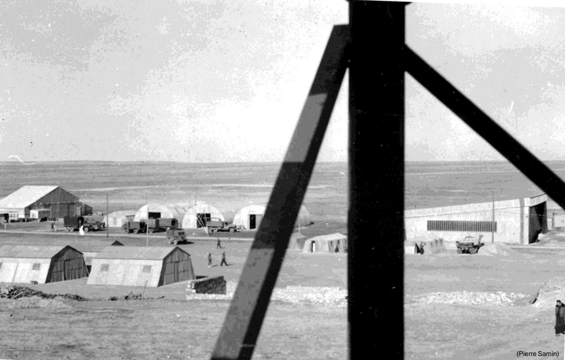
Djelfa – 1956 – Construction de la base – A gauche : le hangar de l'Aéro-club
