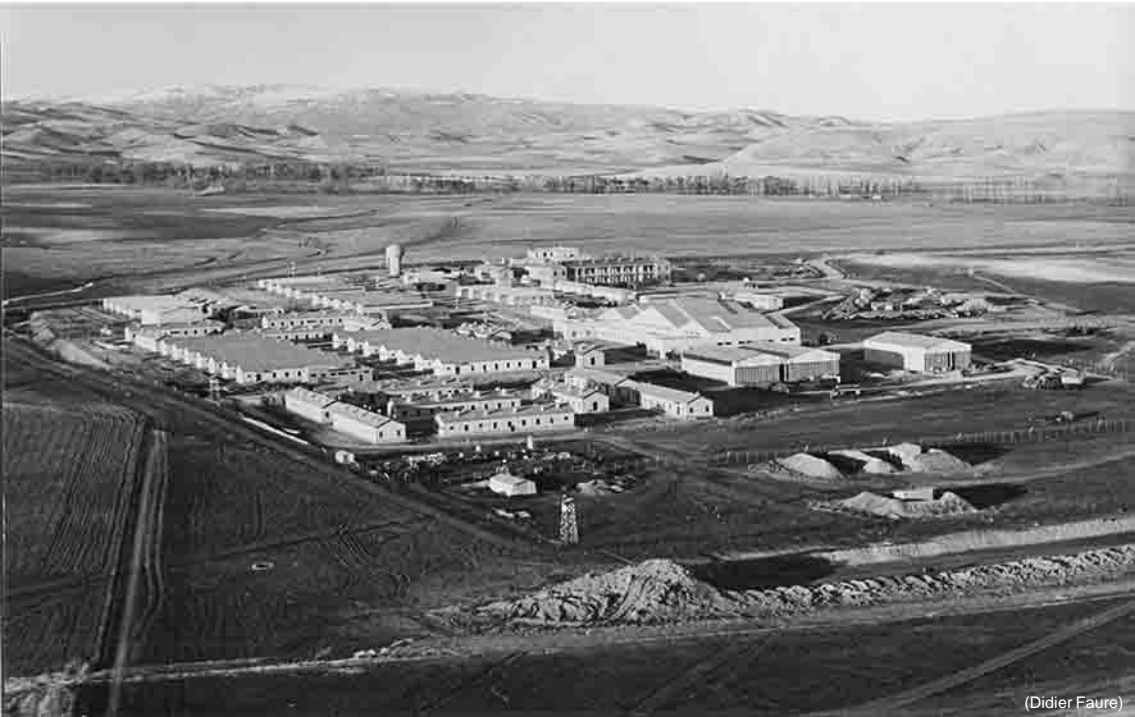
Le Centre d'instruction vu vers le nord, le dépôt de bombes au premier plan à droite
