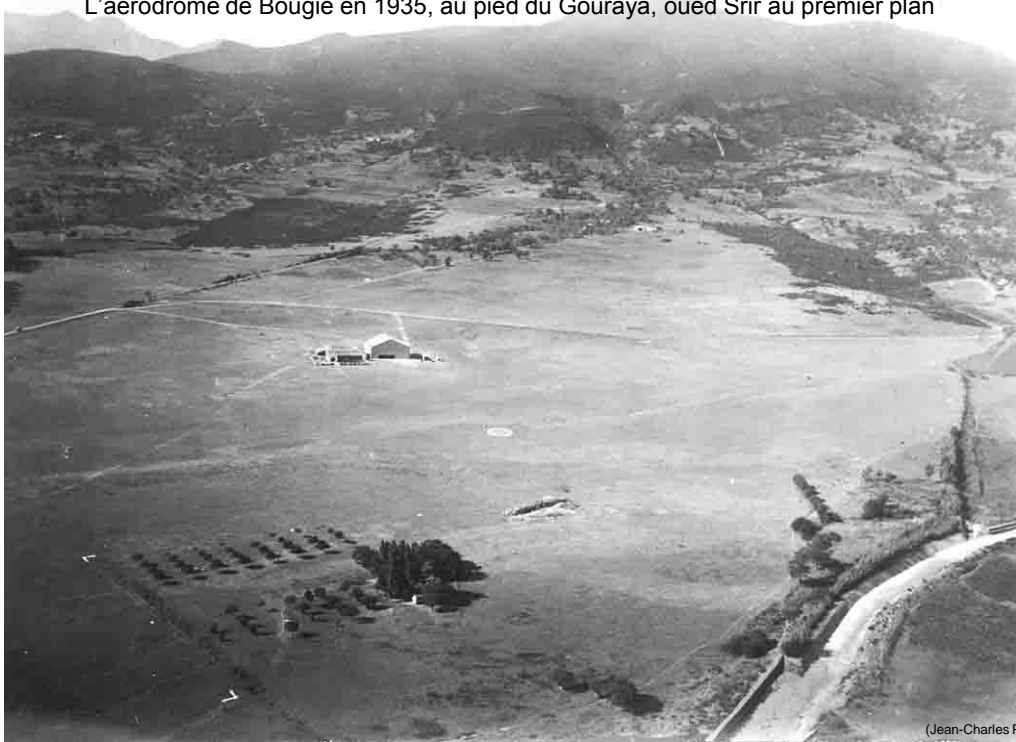
L'aérodrome de Bougie en 1935, au pied du Gouraya, oued Srir au premier plan
