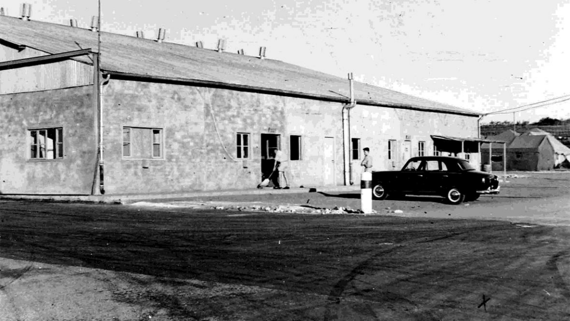
La salle OPS au début de l'installation
