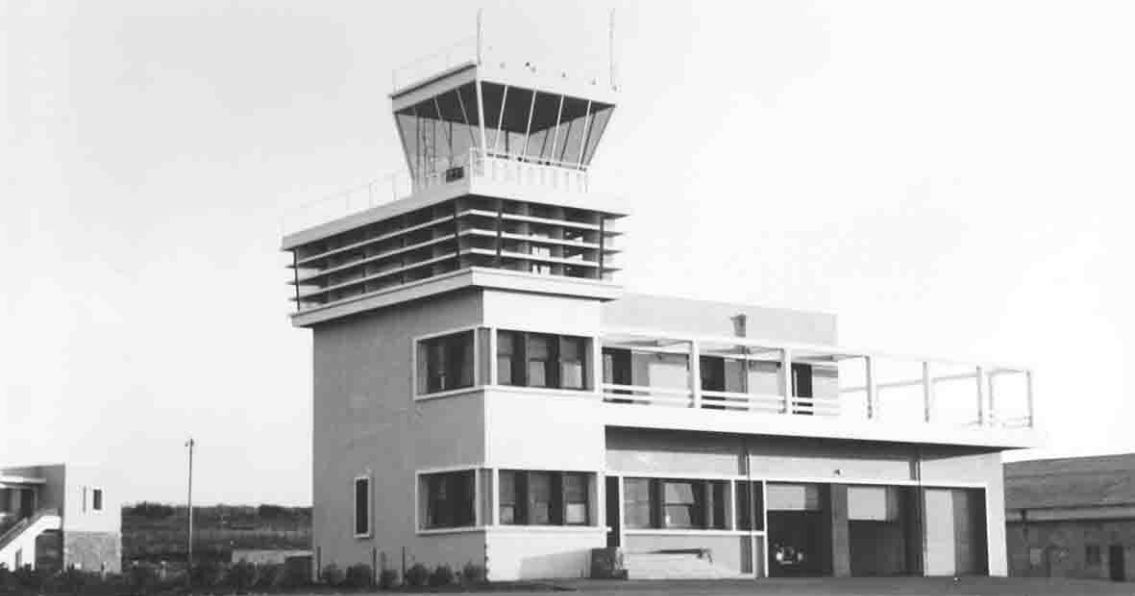
La tour de contrôle et le bâtiment technique vus depuis la piste
