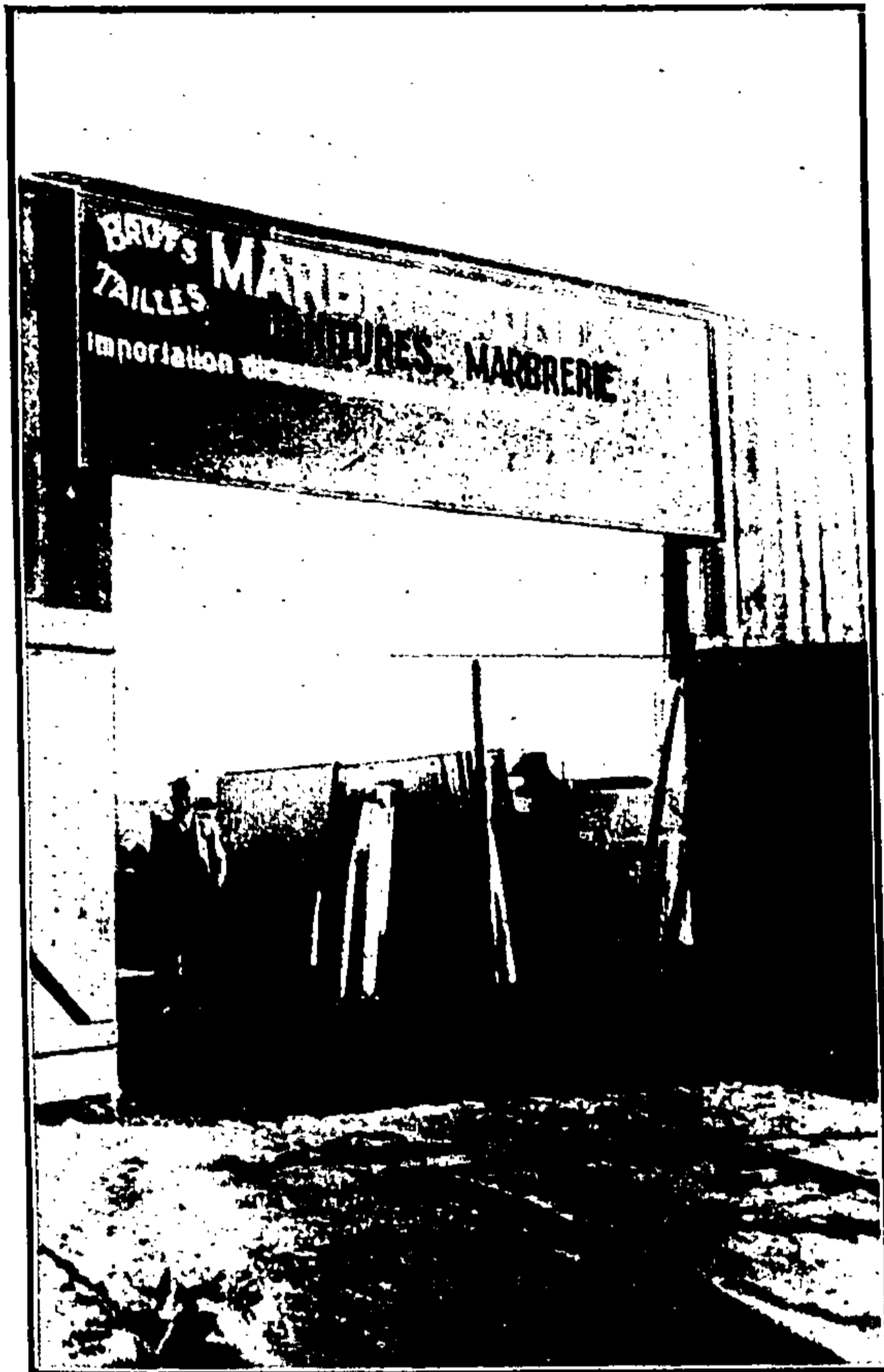
Entrée de la marbrerie.
