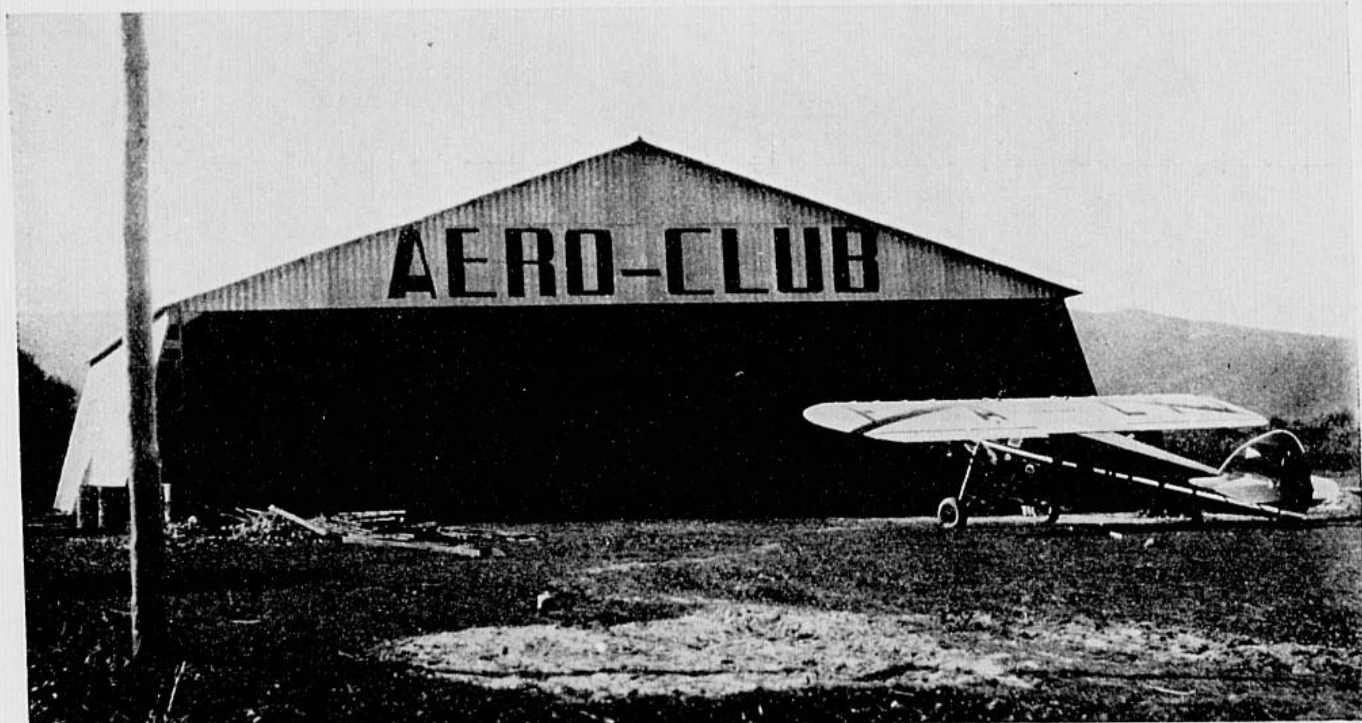
Le hangar de 520 mètres carrés.
