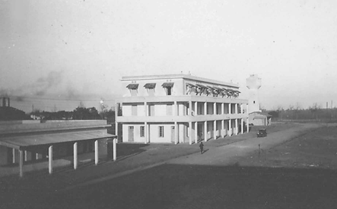
Installations militaires de Maison-Blanche en 1936 (archives privées)
