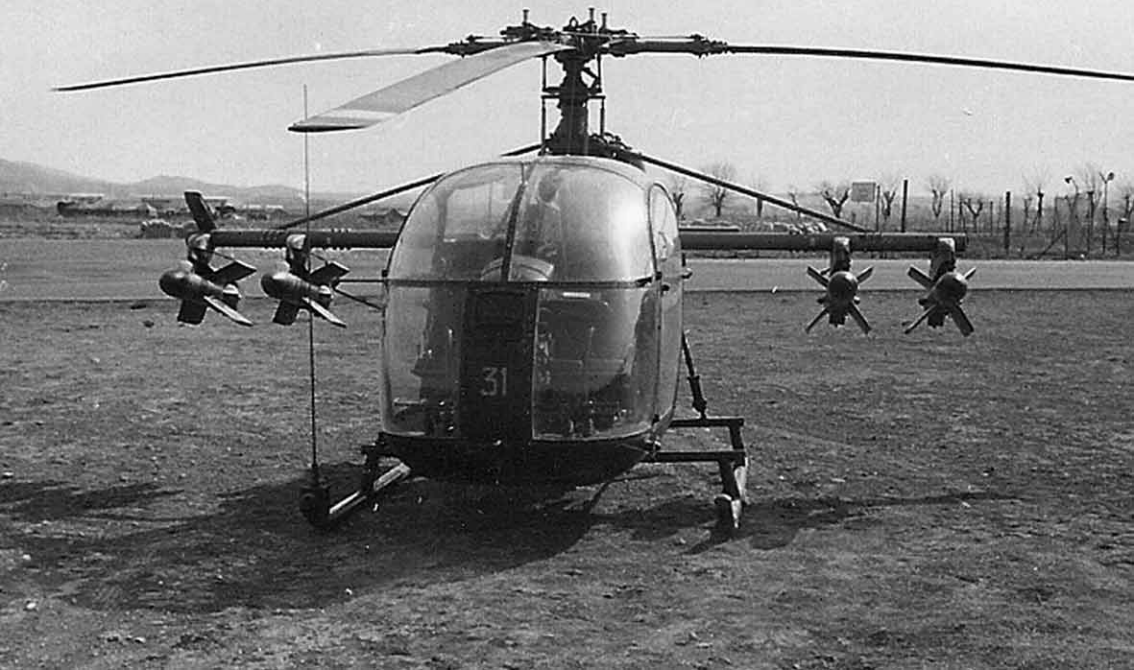
PMAH 19ème DI - Alouette II armée de quatre missiles SS 11 (Norbert Kugel)
