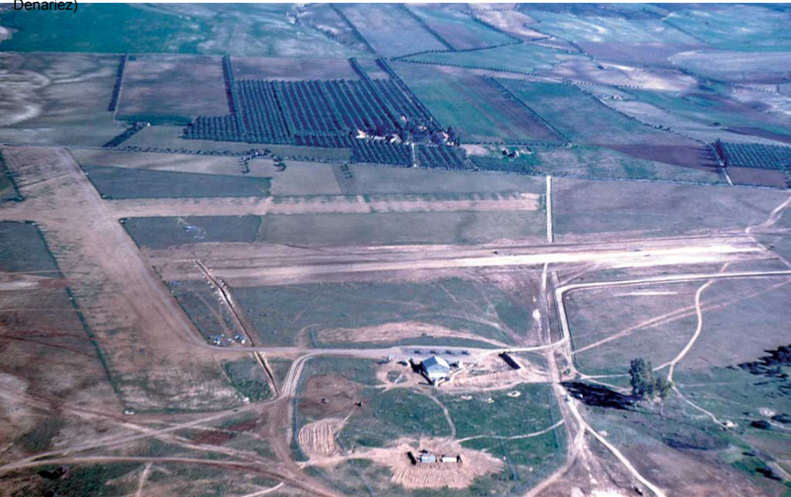
En avril 1960, l'aérodrome de Saïda et le hangar de l'Aéro-club pendant les travaux sur les pistes (Claude Denariez)
