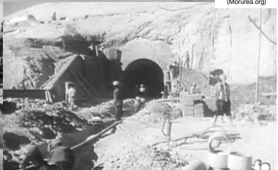
Construction d'un laboratoire souterrain
