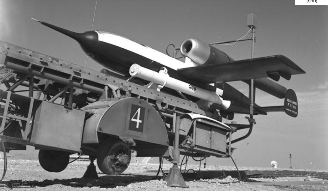
Engin cible téléguidé Nord-Aviation CT-10 (ex-Arsenal 5501) en mars 1960 – Il est inspiré de la bombe volante allemande V1 à pulsoréacteur
