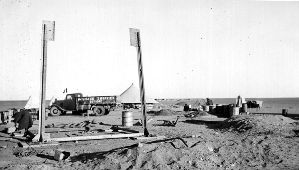
Janvier 1935 – Le Phare Vuillemin en construction à Bidon 5 par la Société Butagaz qui construit également un autre phare à Aouleff. Tous deux sont destinés à faciliter la navigation de nuit. Le Phare Vuillemin sera inauguré le 4 juillet 1935 (Simone Saintpierre)
