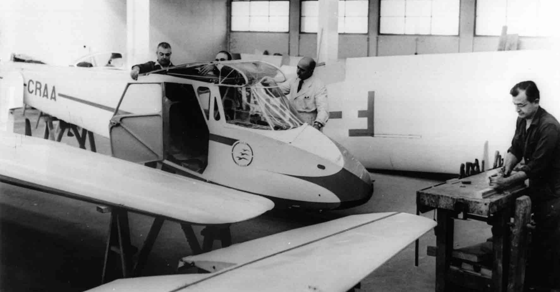
Construction du DACAL ( Direction de l'Aviation Civile en ALgérie ). Le DACAL, dont les plans ont été établis par Charles Rudel et Lucien Saucède, est un planeur école biplace dérivé du SA-104 Emouchet . Le DACAL 105 a fait le premier vol, par Lucien Saucède, le 21 août 1953 au Djebel-Oum-Settas. Un DACAL 105 et huit DACAL 106 ont été construits et ont été utilisés intensément par le Centre du Djebel-Oum-Settas et par l'Aéro-club d'Oranie à Canastel (Lucien Saucède)
