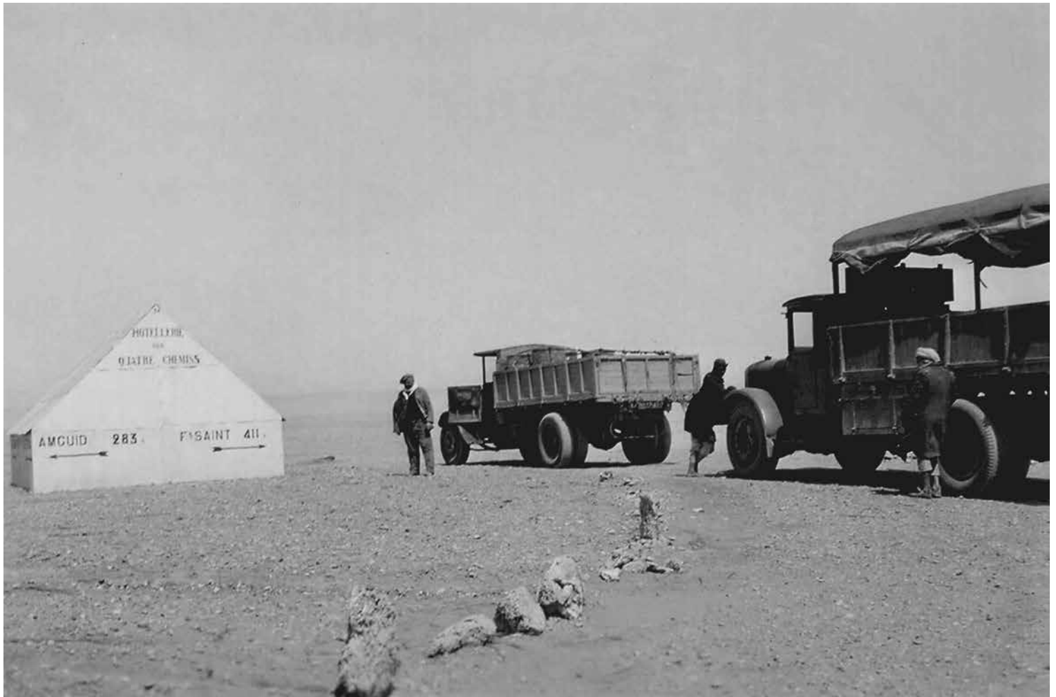
▼ Balise à 14 km de Fort-Flatters en 1936
