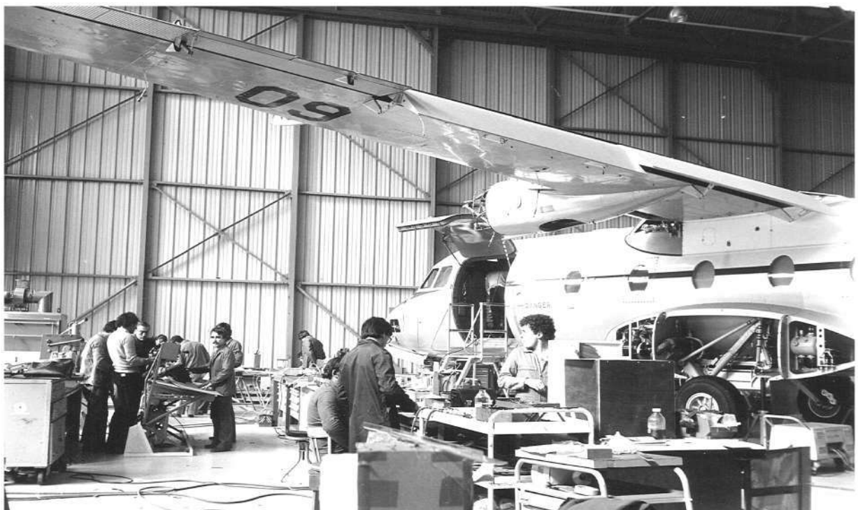
Transformation en version « école » de l'avion de transport Frégate Nord 262
