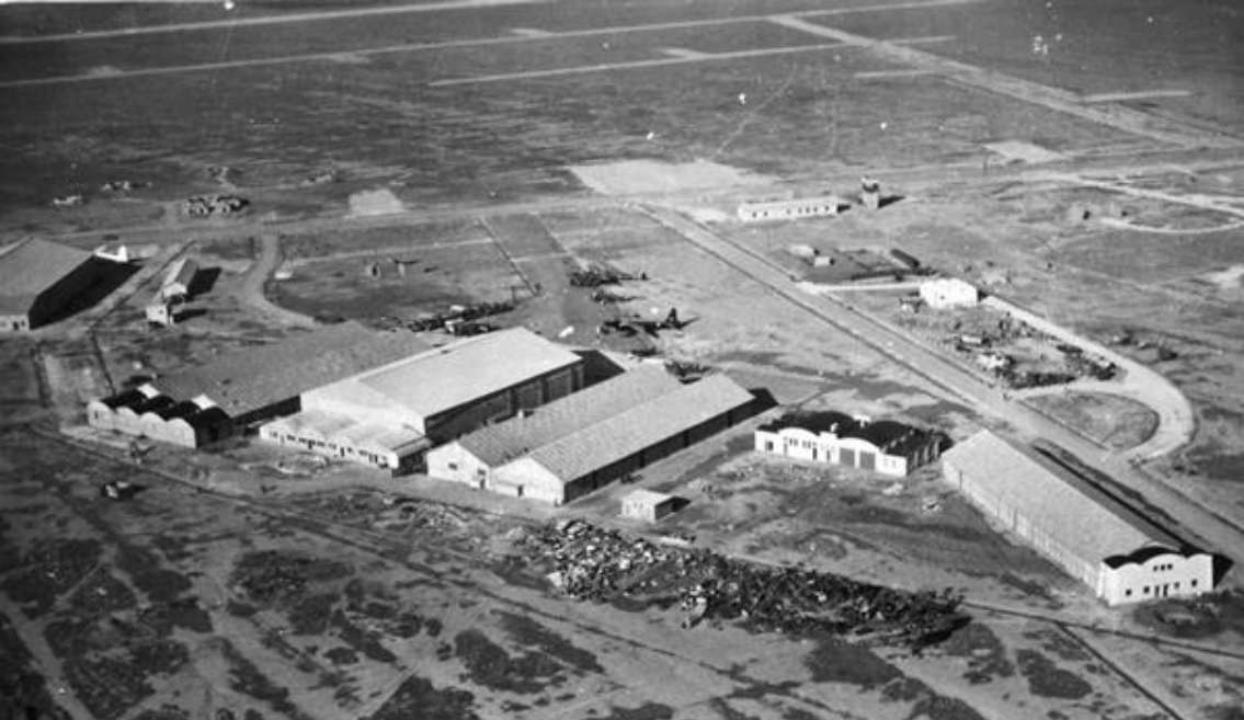
La base aéronavale de Tafaraoui-Lartigue en 1945 – La base a reçu, le 1er août 1941, le nom du contre-amiral Lartigue, ancien commandant du Béarn , qui a trouvé la mort au cours d'un bombardement du terrain de Rochefort le 19 juin 1940 (ARDHAN)
