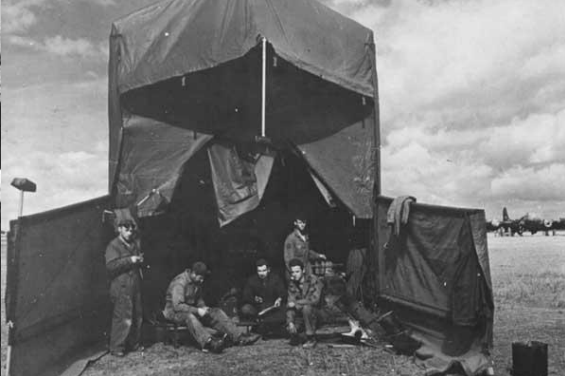
Ain-M'lila, février 1943 – 301st BG – Abri mobile pour changement de moteur, et moteur de B-17
