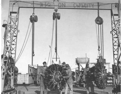
Banc d'essai moteurs et atelier moteurs à Maison-Blanche (IWM et USAF)
