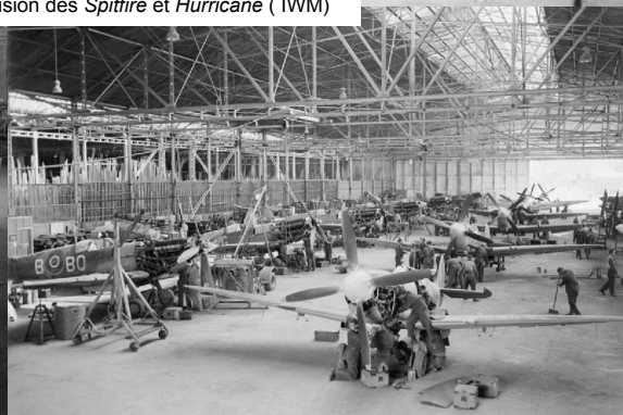
A Maison-Blanche, assemblage et révision des Spitfire et Hurricane ( IWM)
