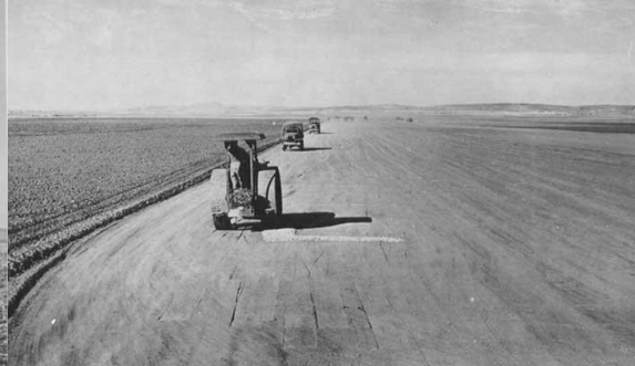
Les plaques PSP Pierced Steel Plank destinées au revêtement (USAF)
