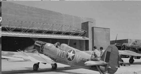
Deux Spittfire de l'USAAF en révision à Maison-Blanche, les mécaniciens sont assis sur la profondeur pendant le point fixe. (IWM et SHD)
