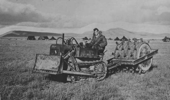
Compacteur à pieds de mouton débarqué d'un C-47 et baptisé ironiquement Opel (USAF)
