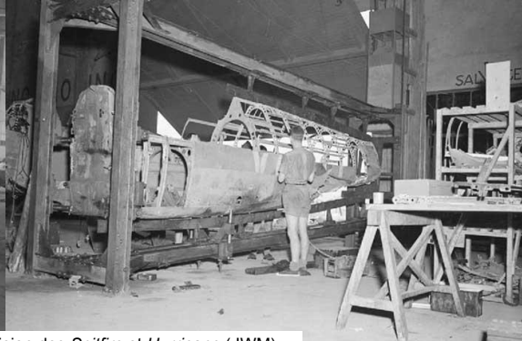
A Maison-Blanche, assemblage et révision des Spitfire et Hurricane ( IWM)
