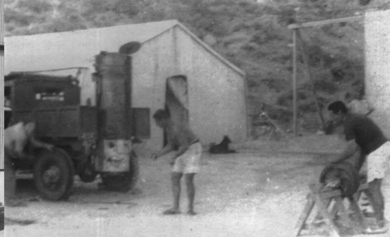
Le câble est enroulé sur la bobine du treuil Chrysler à gazogène
