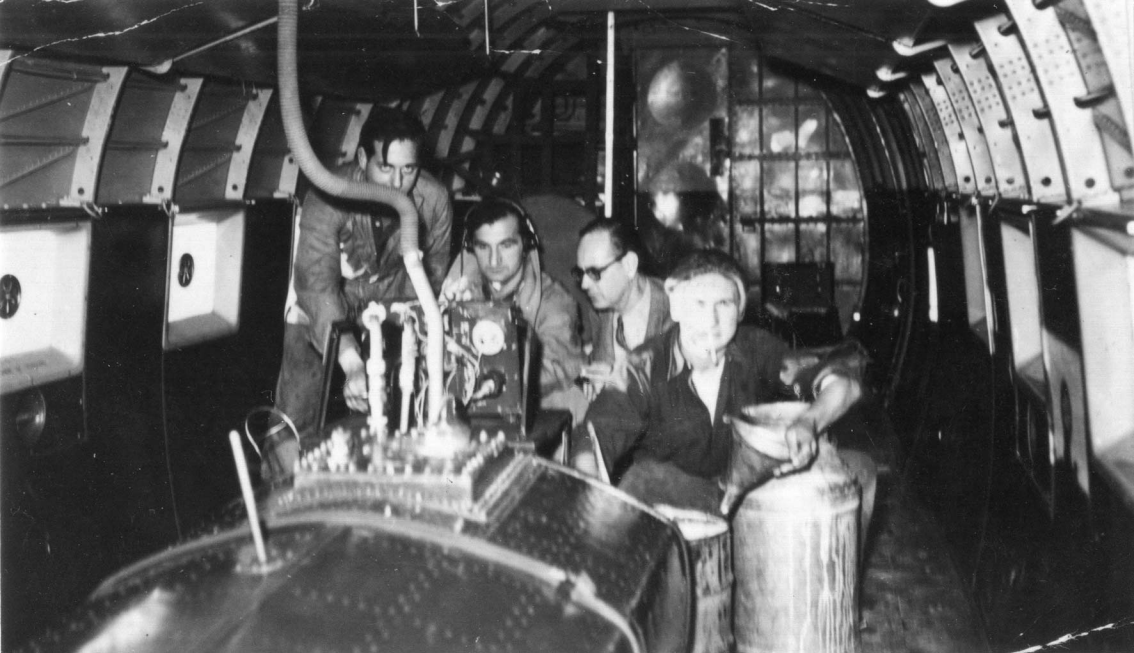
De 1948 à 1950, Pierre Averseng (avec des lunettes) fait des essais de pluie artificielle avec un DC-3 d'Aérotec. Pierre Averseng, agriculteur à El-Affroun, esprit curieux et inventif, a également fait faire de grands progrès à l'archéologie aérienne (Germaine Averseng)
